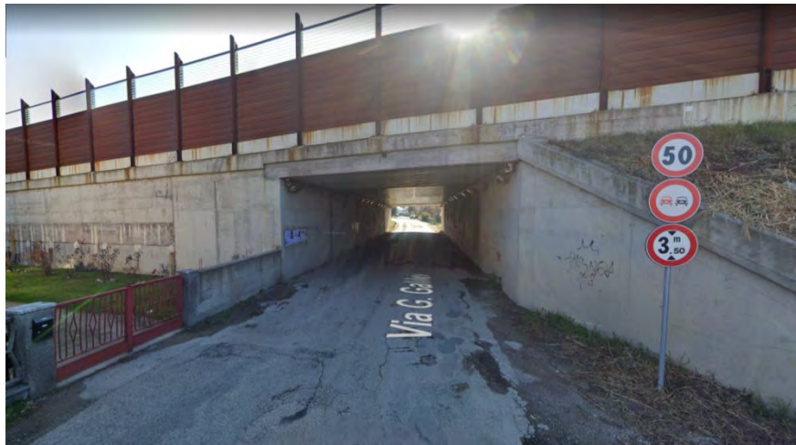
Vista da via Galilei del sottopasso esistente dell'A14 di cui si prevede l'adeguamento, rendendo il percorso in sede propria e protetta
