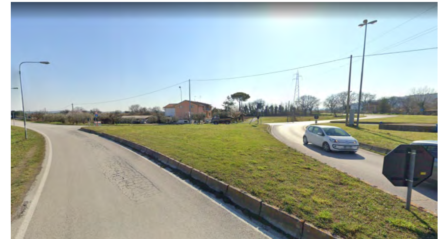
Vista dell'intersezione a raso in loc. Bellocchi (su cui è prevista una rotatoria): la ciclovia correrà in affiancamento alla viabilità esistente, protetta da cordolo invalicabile, fino a raggiungere via Tommaso Campanella
