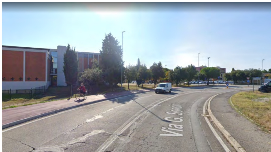
Tratto in cui la ciclovia s'immette sul marciapiede ciclopedonale già esistente di Via Soncino
