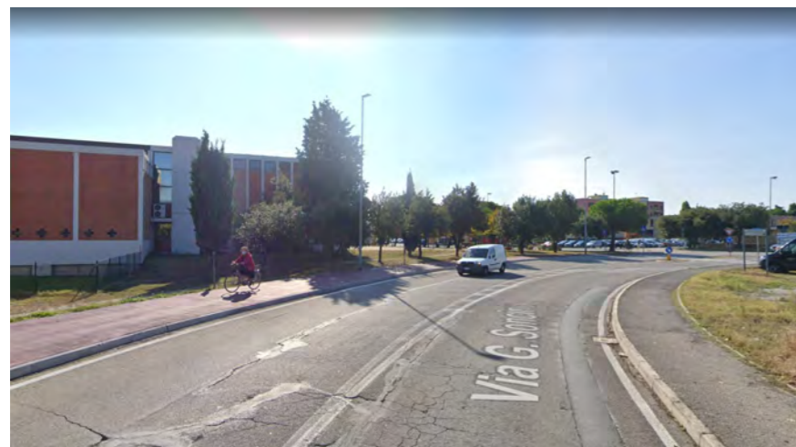
Tratto in cui la ciclovia s'immette sul marciapiede ciclopedonale già esistente di Via Soncino
