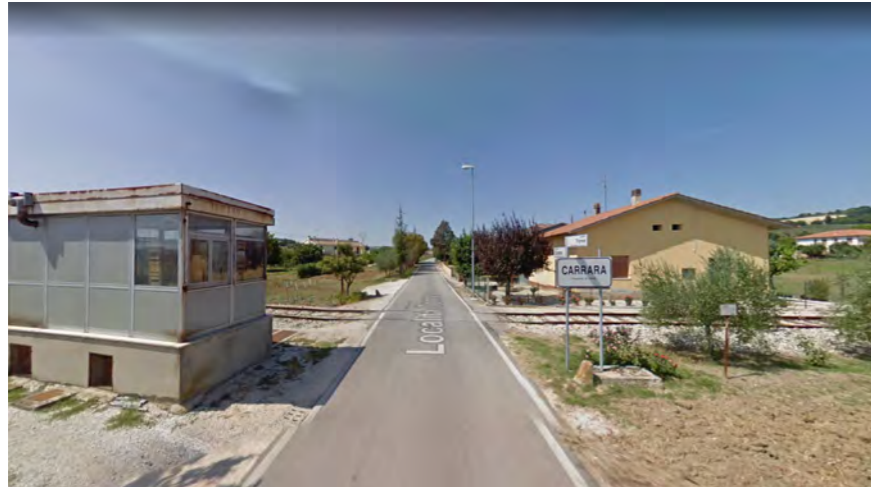
Vista da località Torno del tratto in cui la ciclovia attraverserà la strada, in affiancamento all'ex ferrovia Fano-Urbino
